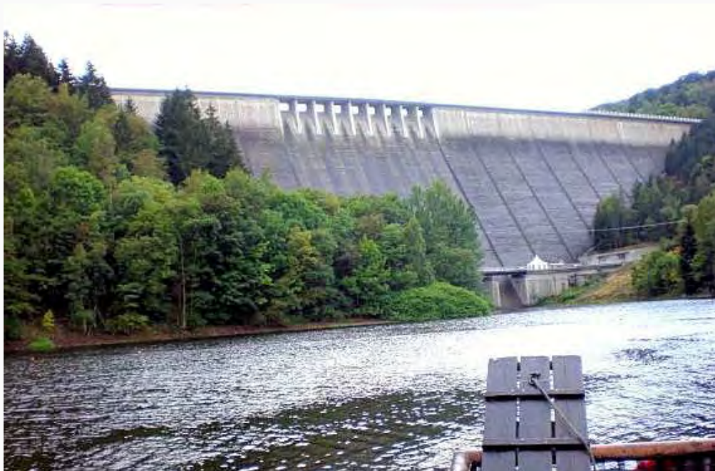
Blick auf die Rappbode-Staumauer vom Floß aus
